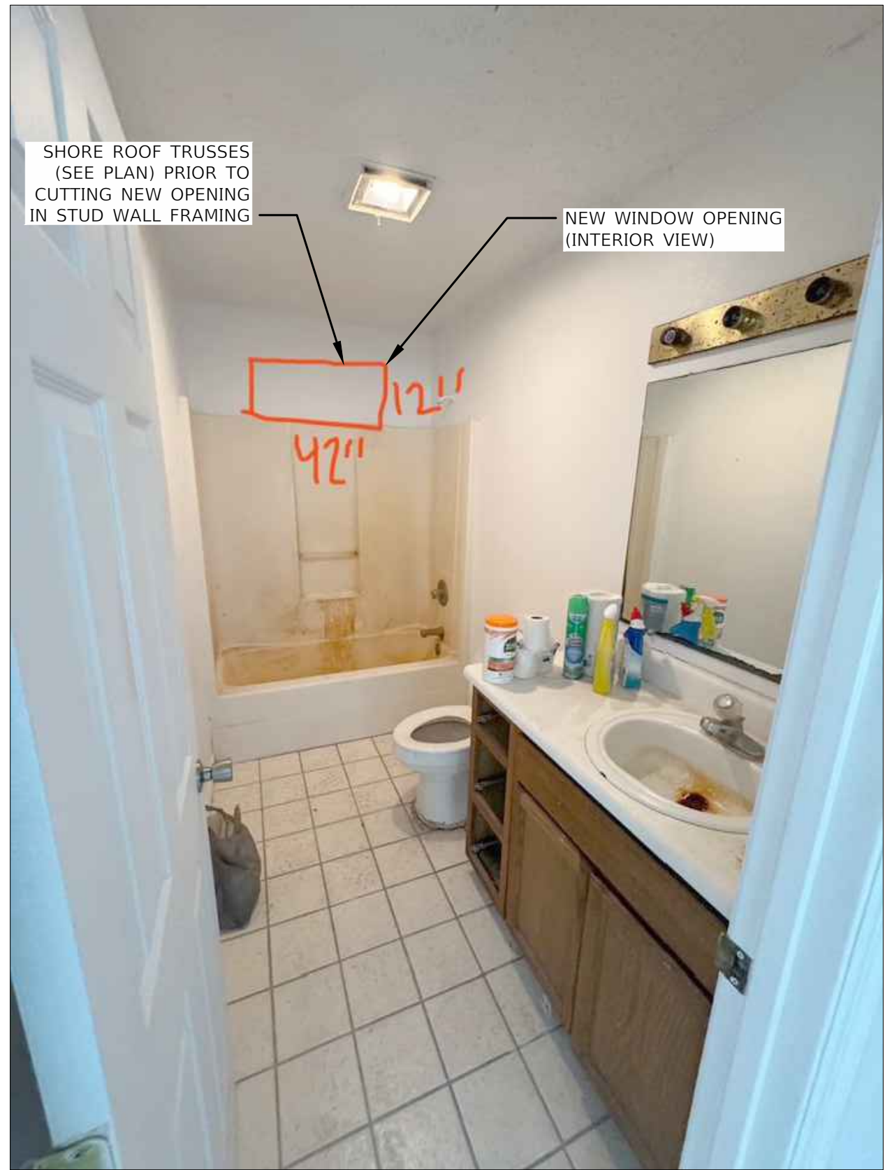
A BATHROOM REPAIR PHOTO DETAIL (INTERIOR) SCALE: N.T.S.
