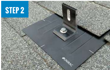
STEP 2 INSTALL L-FOOT
