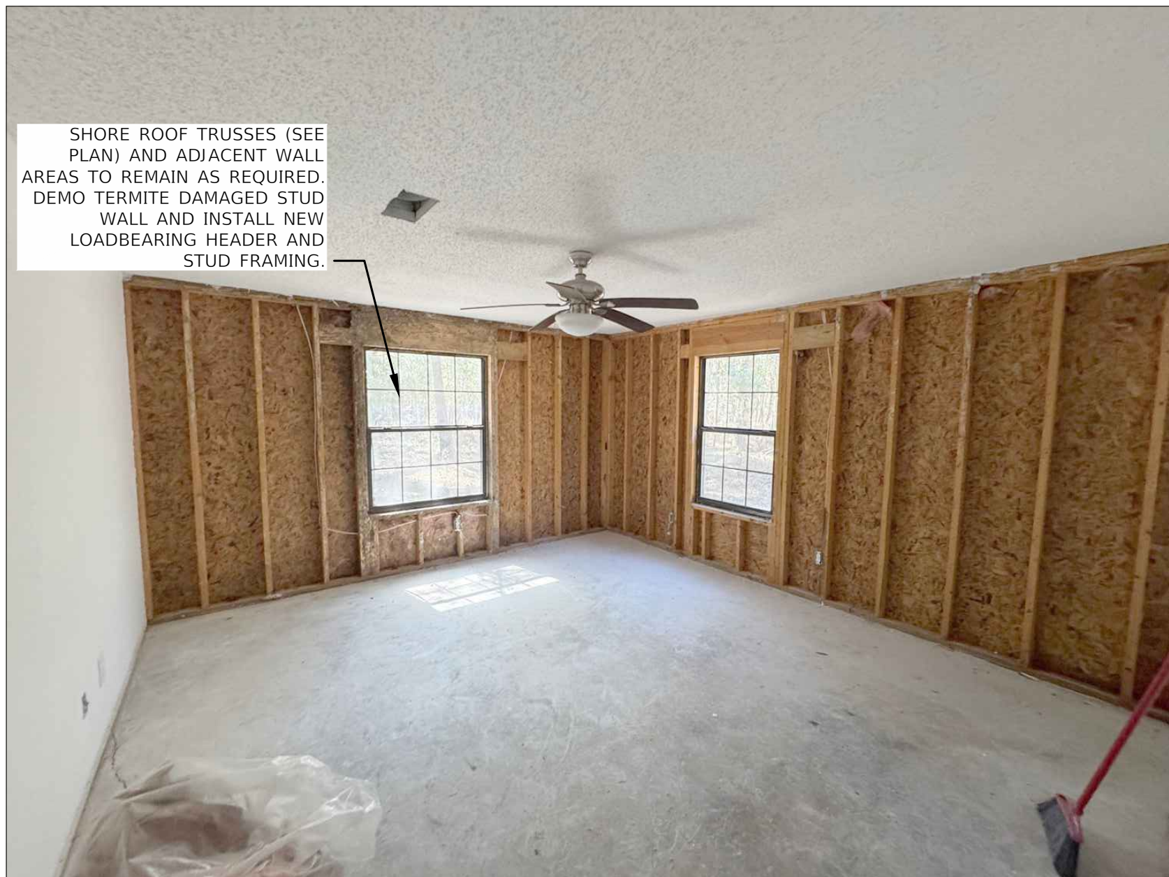
D BEDROOM REPAIR PHOTO DETAIL (INTERIOR) SCALE: N.T.S.
