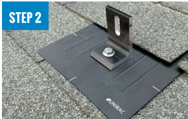
STEP 2 INSTALL L-FOOT
