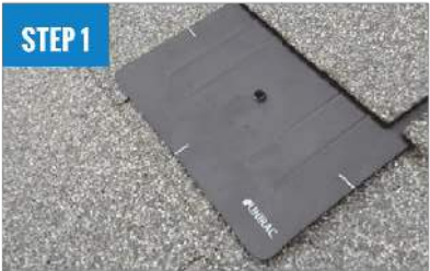
INSTALL FLASHKIT PRO FLASHING
